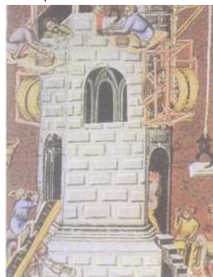
Miniatura del quindicesimo secolo illustra una gru con prolunga piazzata sulla costruzione e azionata da un argano a mano da terra.
