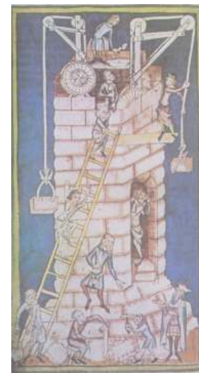
Dall'autore Rudolf von Ems "cronache dal mondo" del tredicesimo secolo la costruzione della torre di Babele è illustrata con due postazioni con gru a carrucole e ruota per azionamento.
